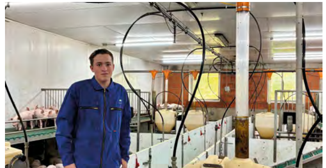
Rundum zufrieden mit der neuen Lüftungslösung: Landwirt Mathias Holsträter im umgebauten Maststall
